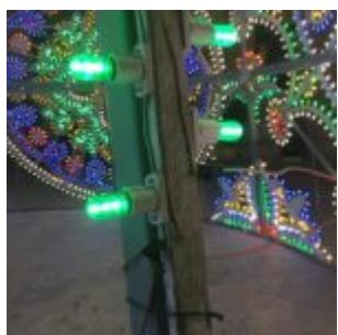
Nella foto, visibili fili elettrici ad altezza bambino con possibili collegamenti con nastro isolante a vista
